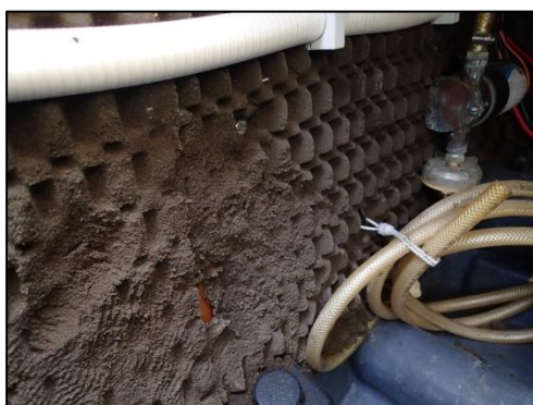
Photo 12 : mousse altérée
