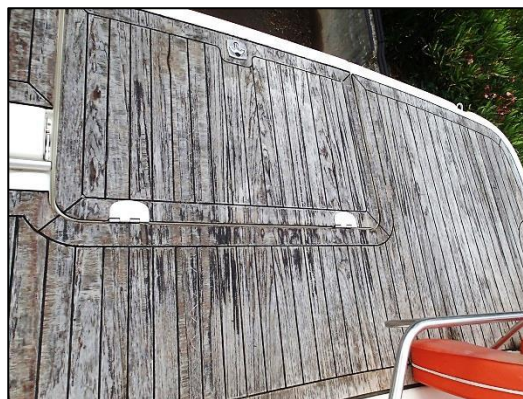
Photo 3 : revêtement en très mauvais état
